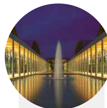
Fiera di Rimini Impianto di produzione acqua refrigerata di tipo centralizzato per il condizionamento di tutto il quartiere fieristico, con sistema di accumulo di ghiaccio per un potenza totale di 21.500kW.
